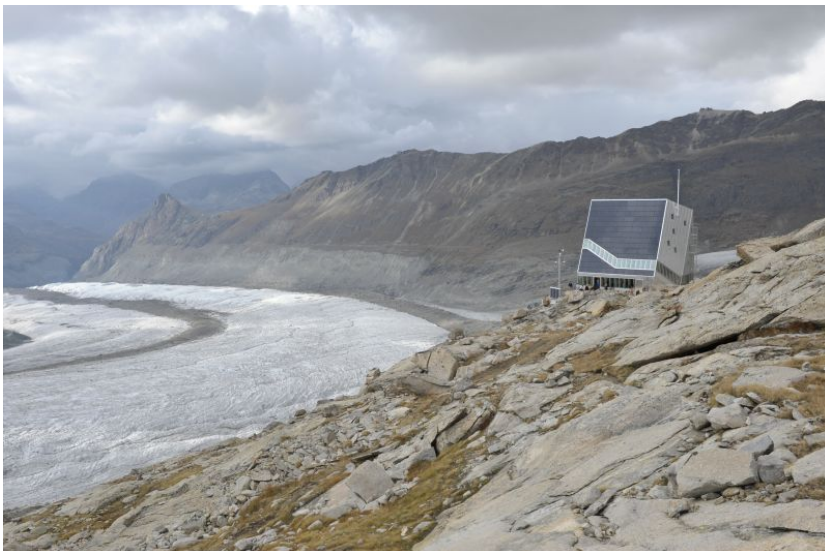
Für die auf 2'883 Metern ü. M. gelegene Neue Monte Rosa Hütte war eine detaillierte logistische Planung notwendig. Durch die abgeschiedene Lage musste der Transport der Baumaterialien gut geplant werden und an die wechselhaften Witterungsverhältnisse angepasst werden.
