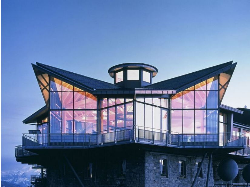
Das Gipfelrestaurant Rondorama auf dem Stanserhorn befindet sich auf 1'900 Metern ü. M. und ist durch die großflächig angelegten Glasfassaden einer extremen Sonneneinstrahlung ausgesetzt. Das Sonnenschutzglas SILVERSTAR SUNSTOP Neutral 50 T verhindert hier eine Überhitzung der Räume.
