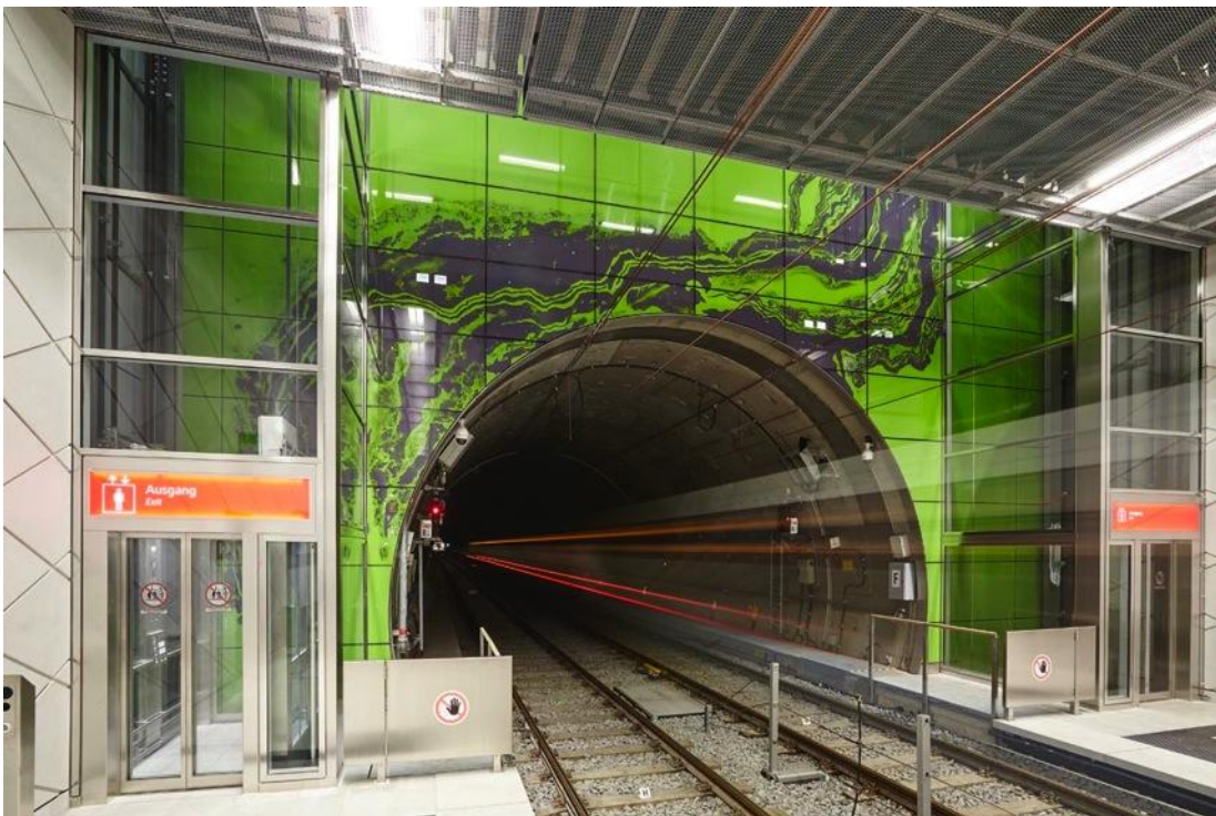
Der Schnittraum des U-Bahnhofs überspannt auch die Fahrtröhre und wurde dementsprechend mit gestalteten Glasplatten versehen.
